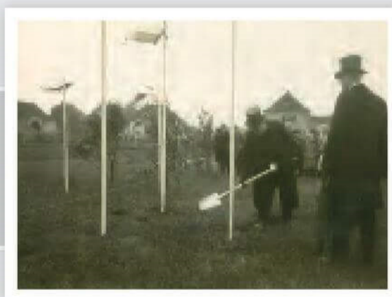
Am 8. Juni 1927, der erste Spatenstich, Bau der Notkirche.
