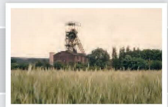
Noch steht der Schacht, rechts im Vordergrund der Schrebergarten „Gut Grün“-Wehofen.
