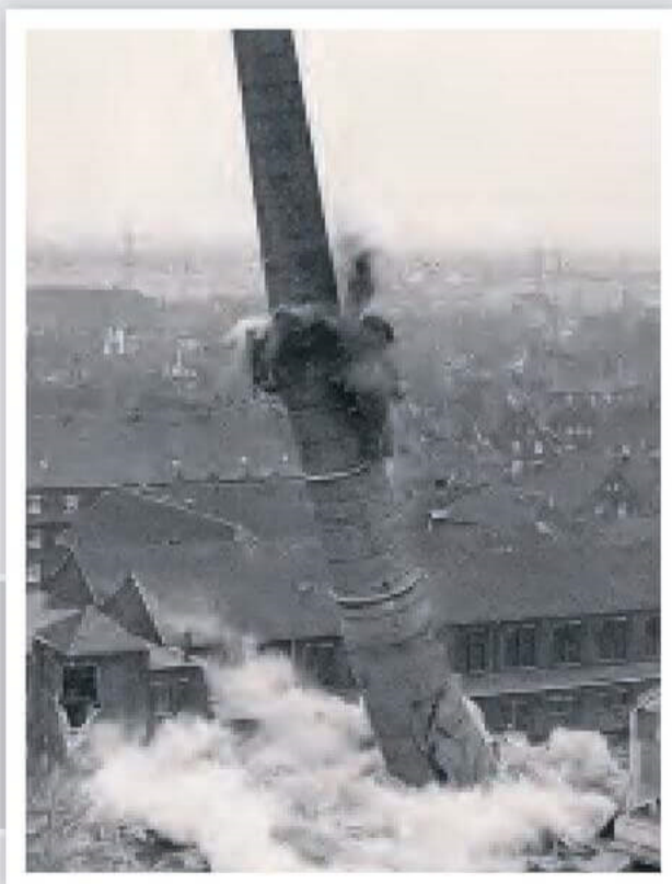
Auch der Kamin wird gesprengt.
